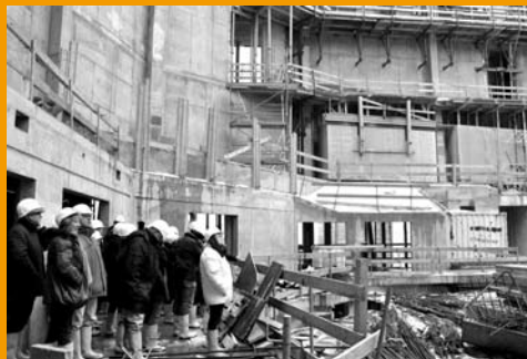
Besichtigung der Baustelle der Elbphilharmonie mit Kulturstaatsrat Dr. Nikolas Hill
